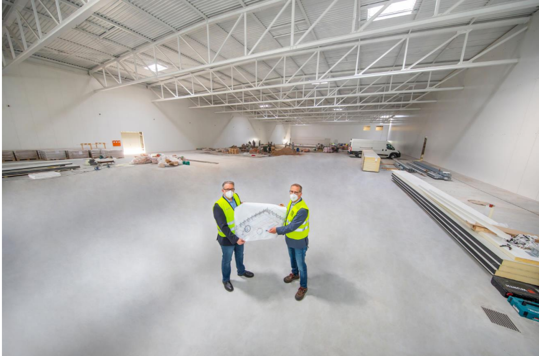
Die modernisierte Halle, in der die neue Abfüllanlage für Dosen montiert wird.
