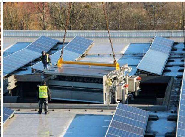
Start der Aufbauarbeiten der neuen Flaschenabfüllanlage im Januar 2020: Die großen Einzelelemente (hier ein Teil der Waschmaschine) wurden per Schwertransport geliefert und übers Hallendach eingehoben.
