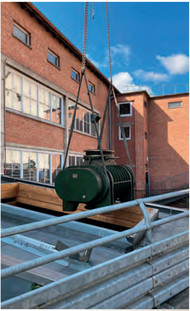
... auch in besonders „schweren“ Fällen: Die STUTTGARTER HOFBRÄU hat ihren 4.000 Kilo schweren mechanischen Bräudenverdichter ausgetauscht. Der Bräudenverdichter nutzt den beim Würzekochen entstehenden Dampf – den sogenannten Bräuden –, um wertvolle Energie zurückzugewinnen. Er hilft der Stuttgarter Hofbräu also, effizienter und nachhaltiger zu brauen.
