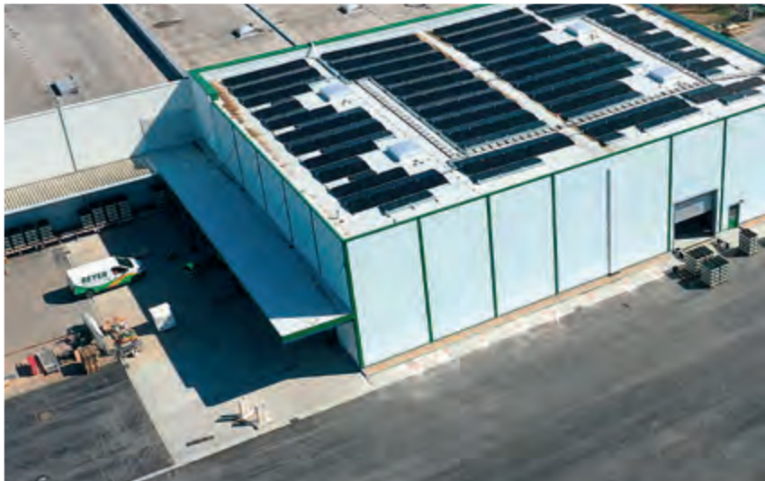
... und unseren Einsatz erneuerbarer Energien mit der neuen PHOTO-VOLTAIKANLAGE IN FREIBERG weiter vorangetrieben. Sie erstreckt sich über einen Teil des Lagers und über die Halle des Neubaus des Projekts „Grüne Wiese“ und deckt mit einer Leistung von 361 kWp mehr als zehn Prozent des gesamten Strombedarfs der Brauerei. Damit spart der Betrieb innerhalb eines Jahres rund 200 Tonnen CO2 ein, was in etwa der Menge entspricht, die 10.000 Bäume in diesem Zeitraum binden können.
