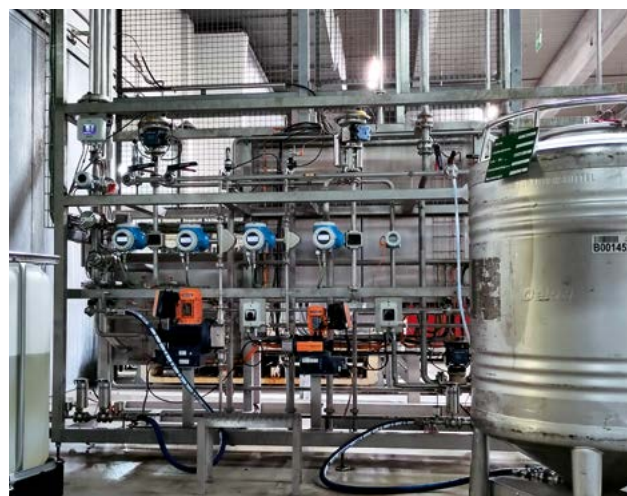
Seit Mai 2023 in Betrieb – die neue Ausmischanlage in Freiberg
